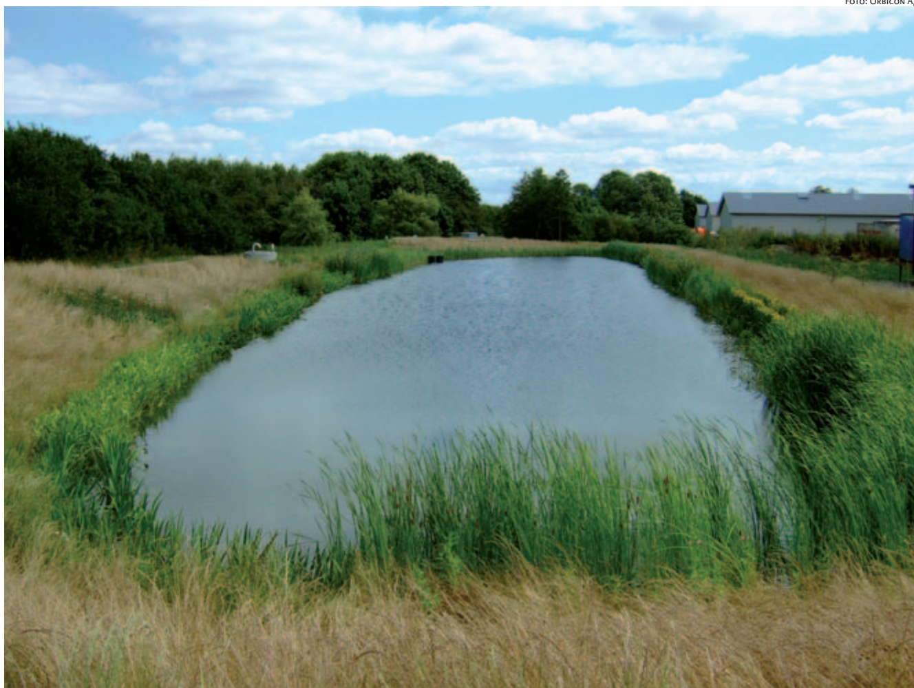
Regnvandsbassinet ved Odense. Det forholdsvis stillestående vand betyder, at forurenende stoffer samler sig, bundfældes og hober op på bunden af bassinet. Opløste stoffer fjernes fra vandfasen i et såkaldt sorptionsrenseanlæg, der er koblet på bassinet i Odense.
