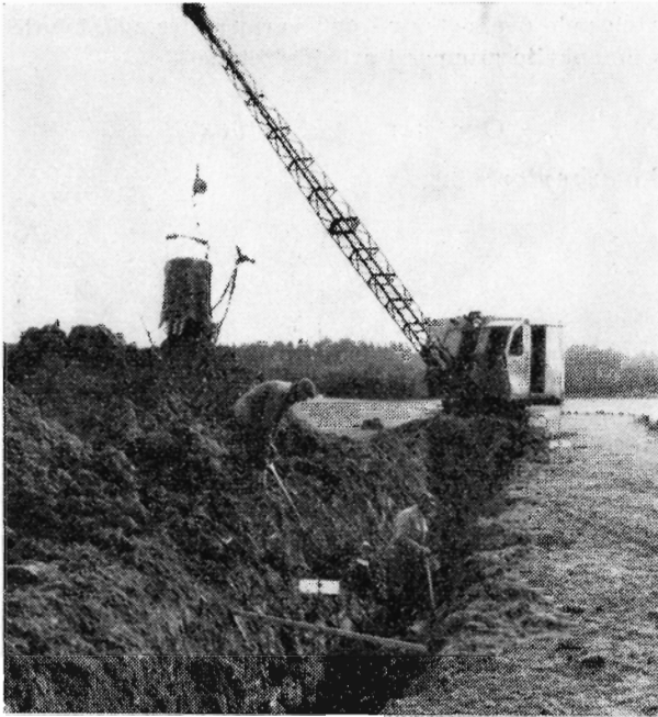
Gravemaskine arbejder på rørledning på Tørning mark.
