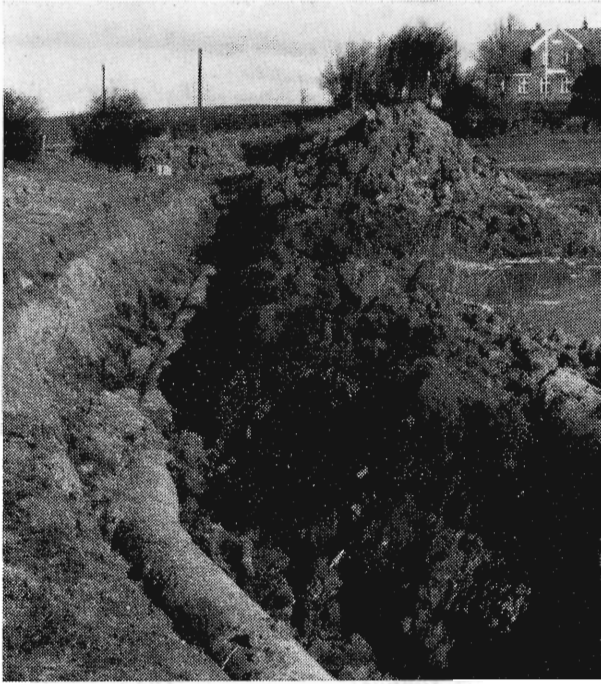
Rørlægning på Tørring mark.
