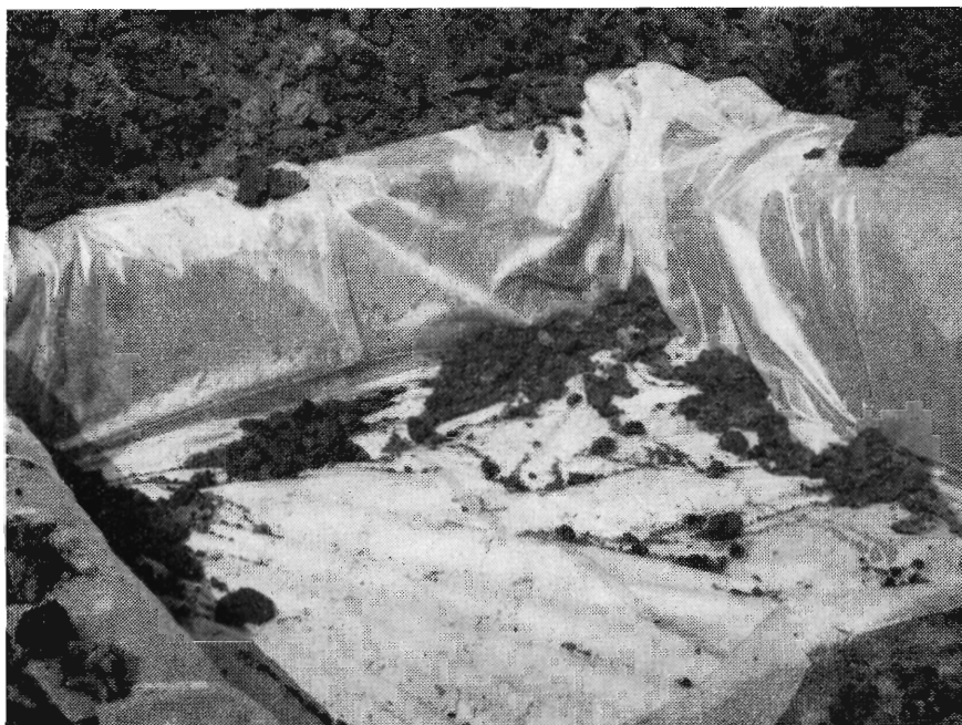
Anlæggelse af dybdebehandlingsforsøg i Skjern-området. Jordgruben udføres med plastfolie, inden den blandede jord lægges tilbage.
