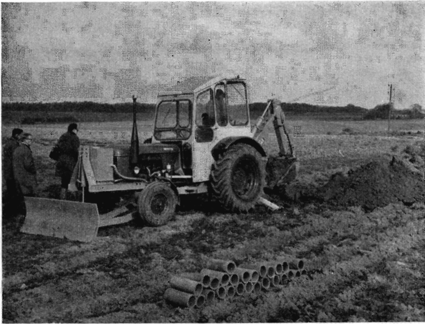
Mindre gravemaskine til drænlægningsarbejde.
