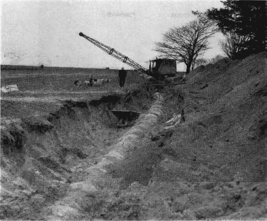
Vandløbet, omtalt foran på Viuf vestermark, aflastes nu ved en rørlægning til Almind å, næsten på tværs af den tidligere retning, fot. 1963.
