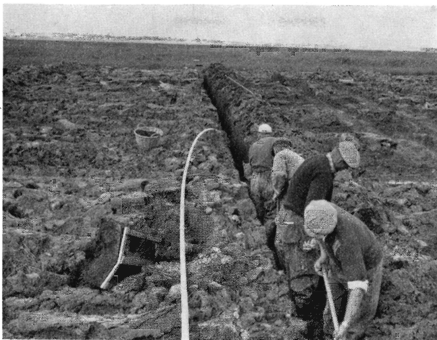
Nedlægning af hollandske plastrør på et forsøgsareal.
