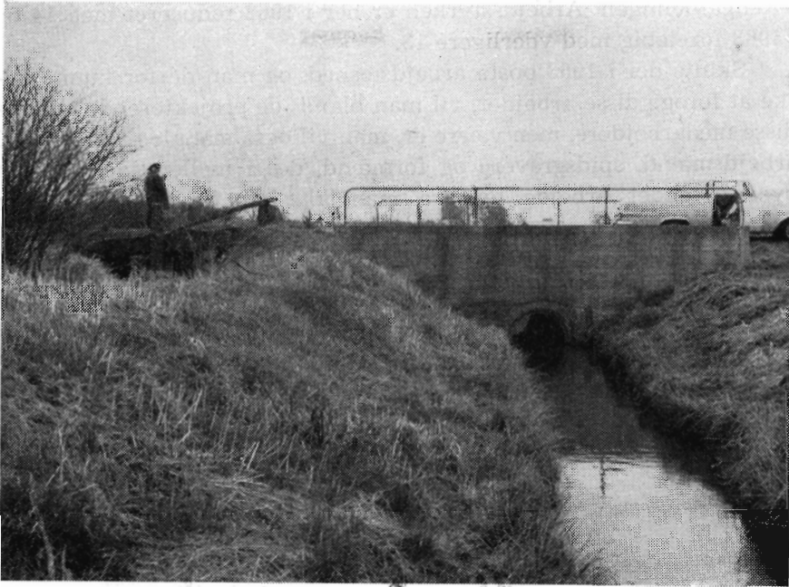
Den nye bro over Fiskebæk, der afløser den gamle kampestensbro, der ses tilvenstre, fot. 1963.
