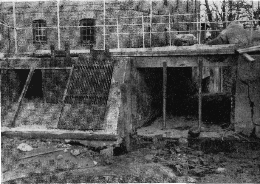
Det gamle gennemløb til mølevirksomheden ved Kjærsmølle sydøst for Kolding er ikke mere i brug, men rørlagt.
