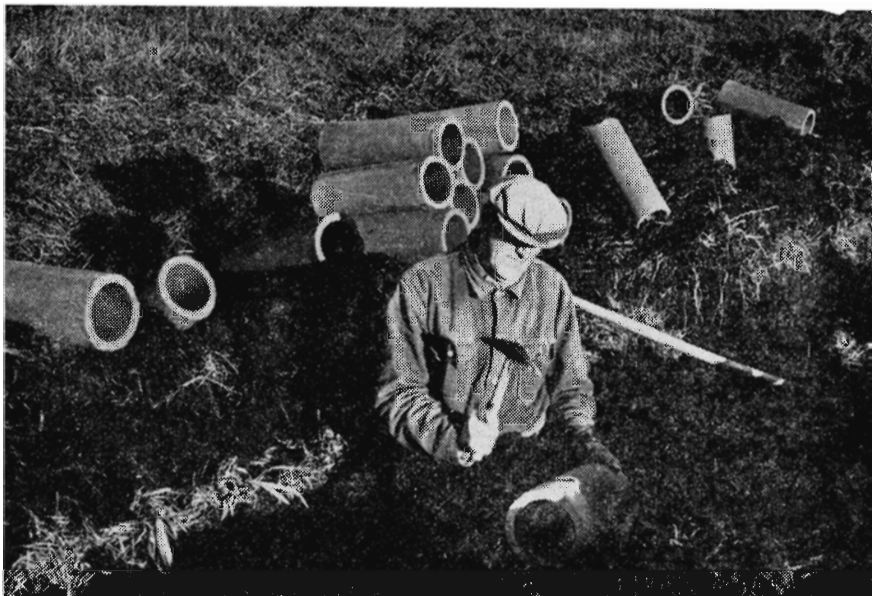
Den øvede rørlægger bruger spidshakken til tilhugning for sidedræn.
