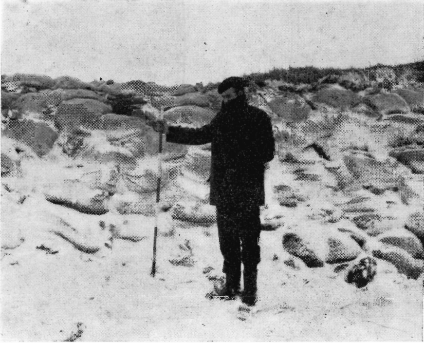
I februar rettede højvandet alvorlige angreb på Manødiget, således at der opstod fare for gennembrud. Her ses et af de mest udsatte steder, hvor et gennembrud kun hindredes ved sikring med sandsække. Fot. 1962.
