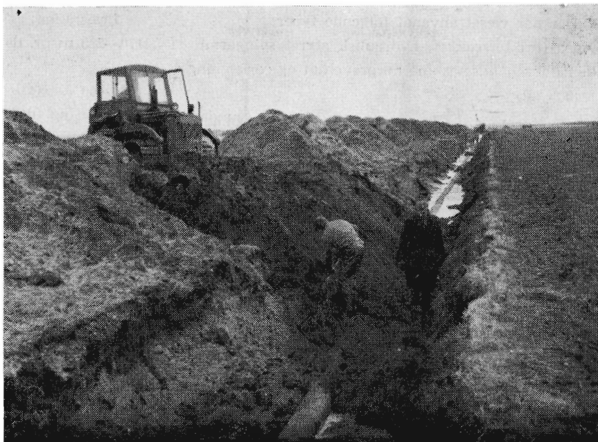
Der jævnes med skovl, hvorefter bulldozeren tager fat.
