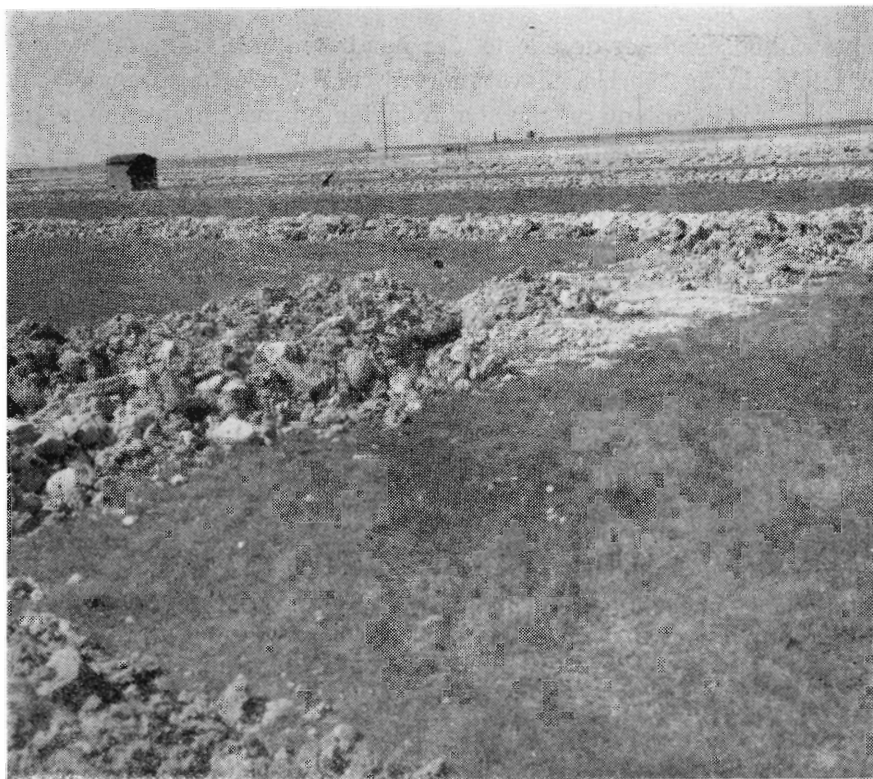
Detaildræning under udførelse på »Gyldensteen«.
