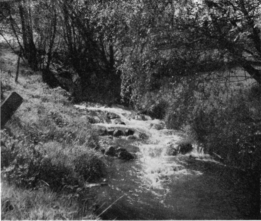
Ældre styrt (træspunsvæg og stenkastning) i Tange å.
