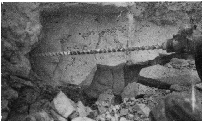
Der bores for sprængning i Mønsted kalkbrud.
