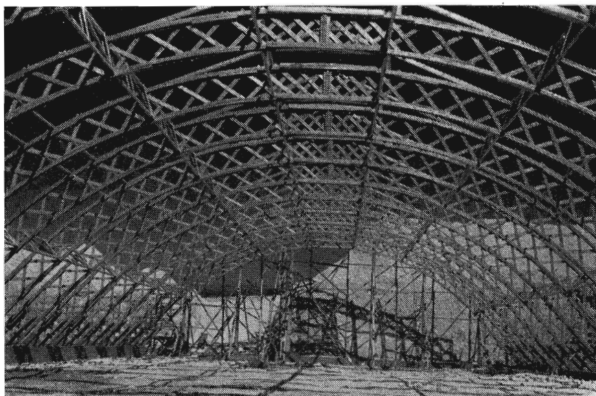
Civilingeniør K. L. Kristensen, Varde, bygger kalklade i Mjels 1959.
