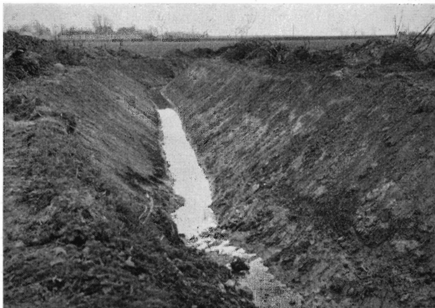
Vandløb på Falster med afløb fra mejeri og rensningsanlæg. Vandløbet skal rørlægges gennem et beboelsesområde, fot. 1960.
