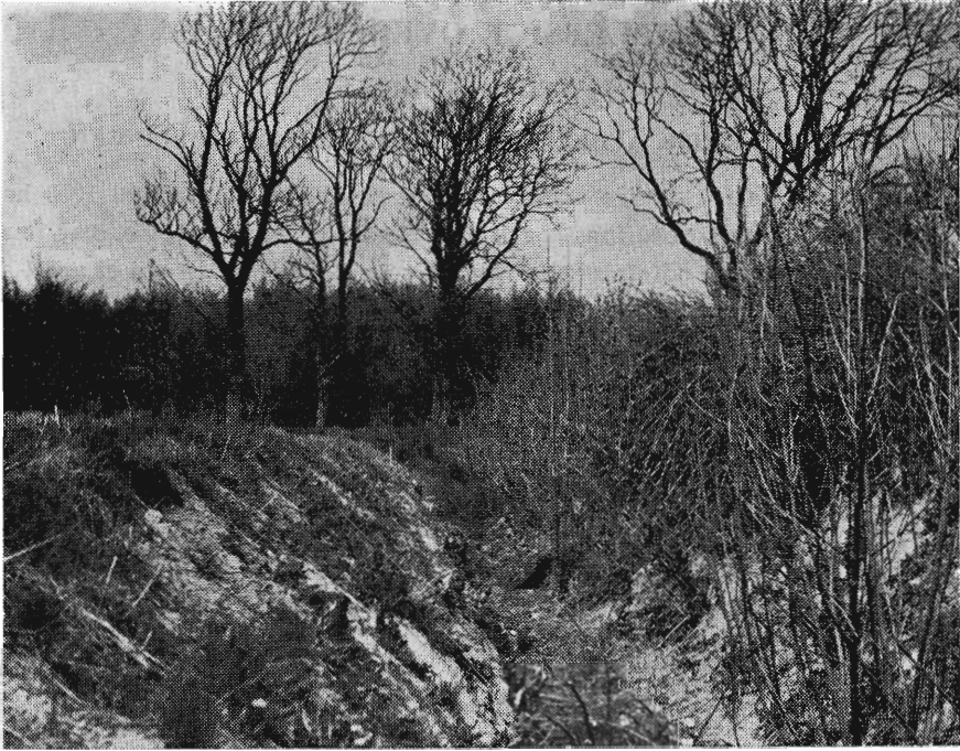
Rørlagt grøft på Lolland, hvor grøften skal bevares, så den kan bortlede ekstraordinære afstrømninger. Efter kendelser må siderne ikke være bevoksede og affald ikke kastes i grøften — det kniber stærkt med begge dele.
