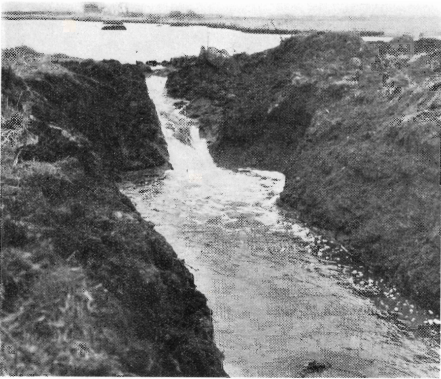
Afvandingskanalen er ført frem til en af de store tørvegrave i Resen kær ved Struer, og tørvegravens vandmængde er lukket ud i kanalen. Det tog knap 3 dage at tømme tørvegravene. Faldet var godt 2 m.
