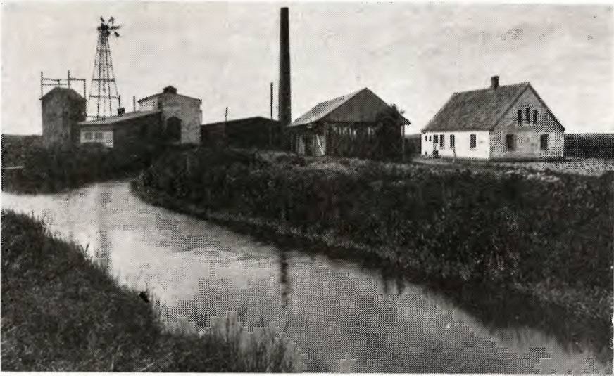
Pumpestation i Tastum sø ca. 1912 med den gamle vindmølle, den hollandske vandsnegl, dampskorsten m. m.
