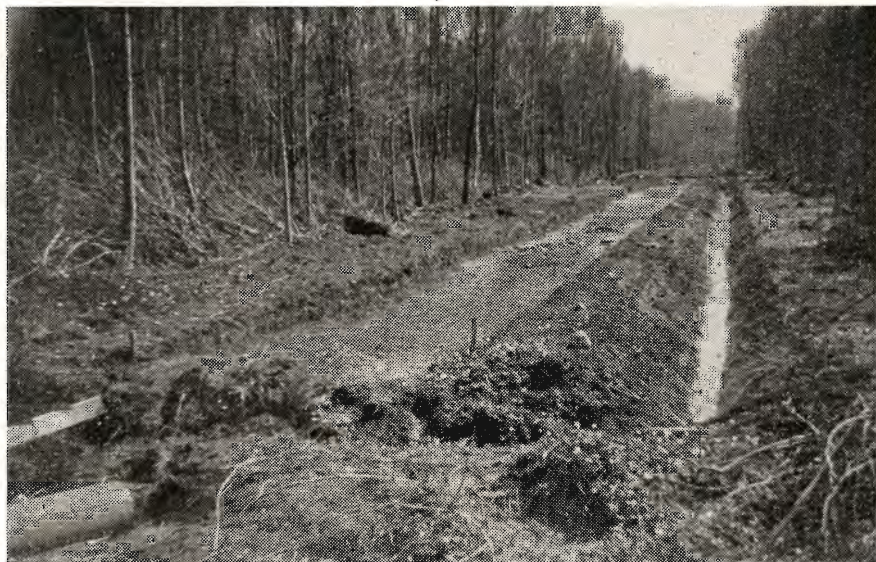
Vej under udførelse gennem Rødding præstegårdsskov. Arbejdet udføres af Hedeselskabets flyvende Korps (beskæftigelsesforanstaltning B. 1).
