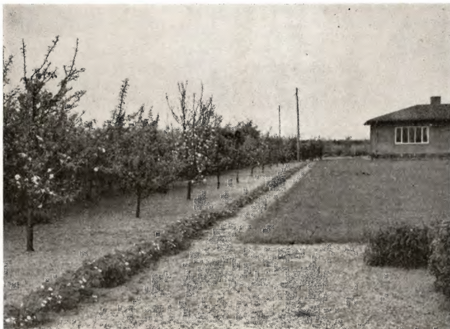
Fra haveanlægget ved forsøgsarealet i Karup.
