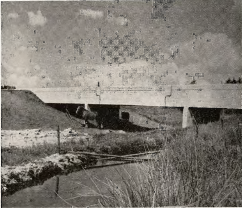
Aquadukt, der fører den nordre Skjernaakanal over et mindre vandløb ved Skarrild. Fuldført 1950 efter at et voldsomt regnskyl havde ødelagt den gamle kanalovertføring.
