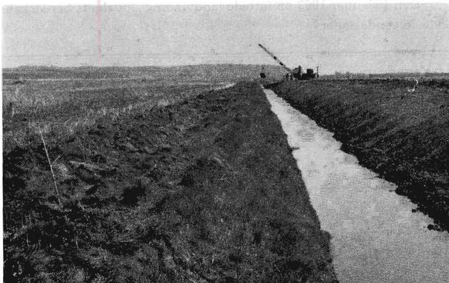
I Slib sø kan gravemaskinen nu trygt arbejde med uddybning af samlekanalen midt gennem den tidligere sø, fot. maj 1963.
