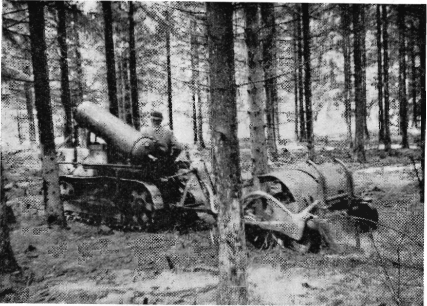
Demonstration af materiel til udsprøjtning af flydende ammoniak som forsøg i nåletræsbevoksning.
