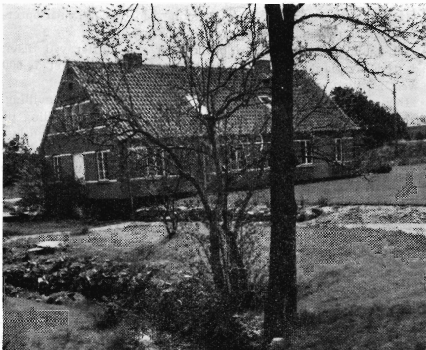
Skovriderboligen i plantagen C. E. Flensborg. Det er stuehuset til den gamle Nr. Borup vandmølle, der er ombygget indvendig.
