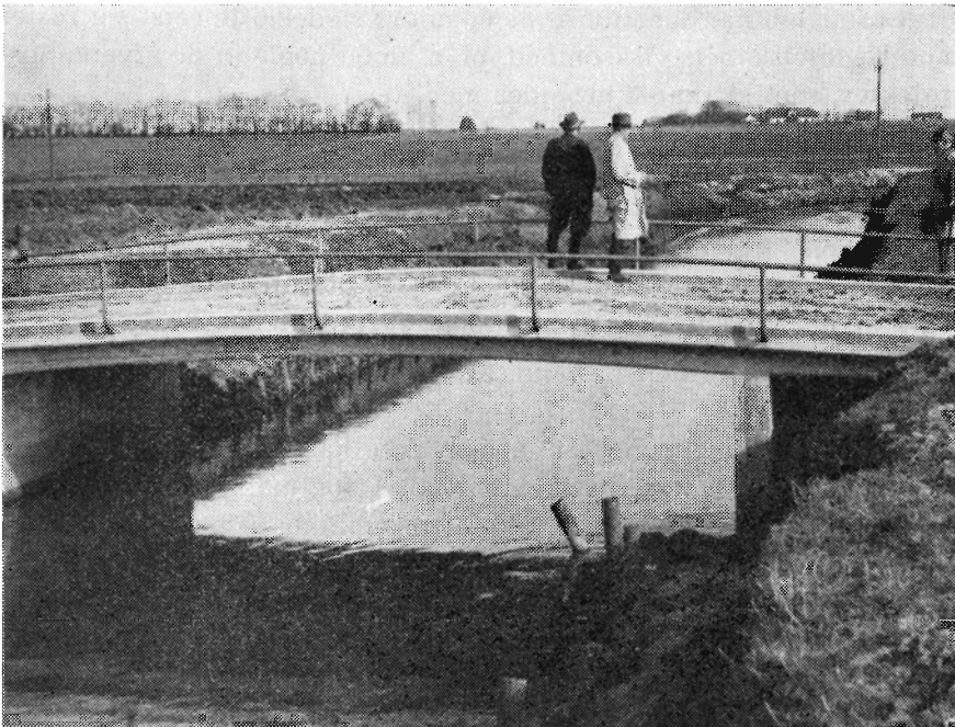
Markvejsbro over det nygravede løb for Herningsholm Å ved Gjødstrup Sø.
