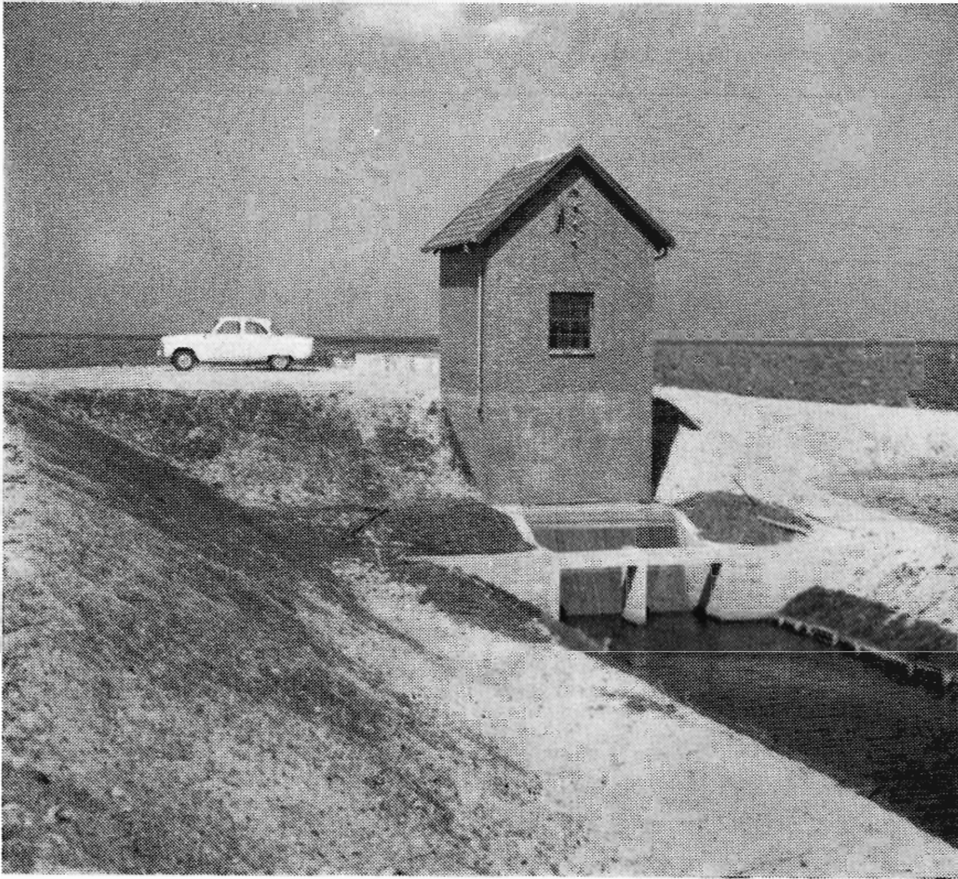
Elektrisk, automatisk pumpestation for Gyldensteen Inddæmning. Man ser i baggrunden havdiget og øjner horisonten over havet. De inddæmmede arealer udgør 420 ha, og anlægget omfatter pumpeanlæg samt afvandingskanaler, rørledninger, dræning og vejanlæg. Endvidere dybdepløjning på en del af arealet.
