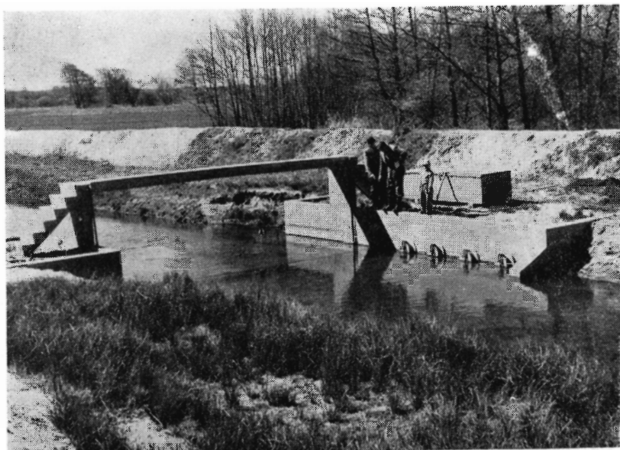
Fordelingsbygværk ved Korup å i Visborg enge.
