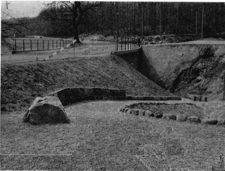
Fra landvindingsarbejdet omkring Åmosen ved Holbæk. Den nye Bromølle øverst set fra syd. En gangsti fra krohaven er ført gennem selve vandsluget på en udkraget plade. Nederst ses gangstinedføringen fra krosiden.
