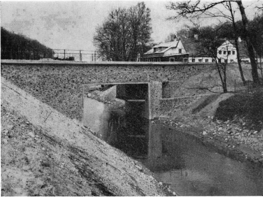
Fra landvindingsarbejdet omkring Åmosen ved Holbæk. Den nye Bromølle øverst set fra syd. En gangsti fra krohaven er ført gennem selve vandsluget på en udkraget plade. Nederst ses gangstinedføringen fra krosiden.
