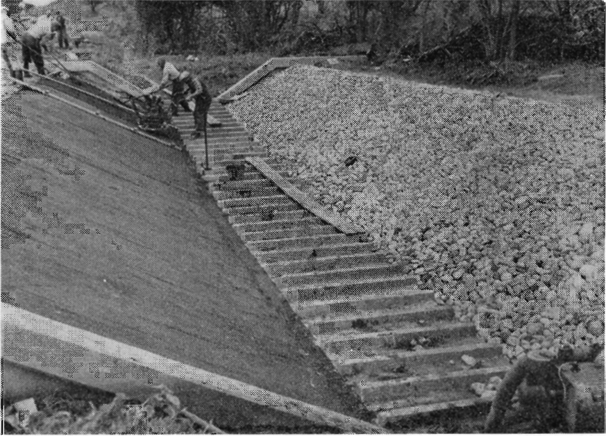
Stryg i Ørsted bæk i Sommersted. Faldhøjde 0,8 m, længde 9 m med fald 1 : 12.
