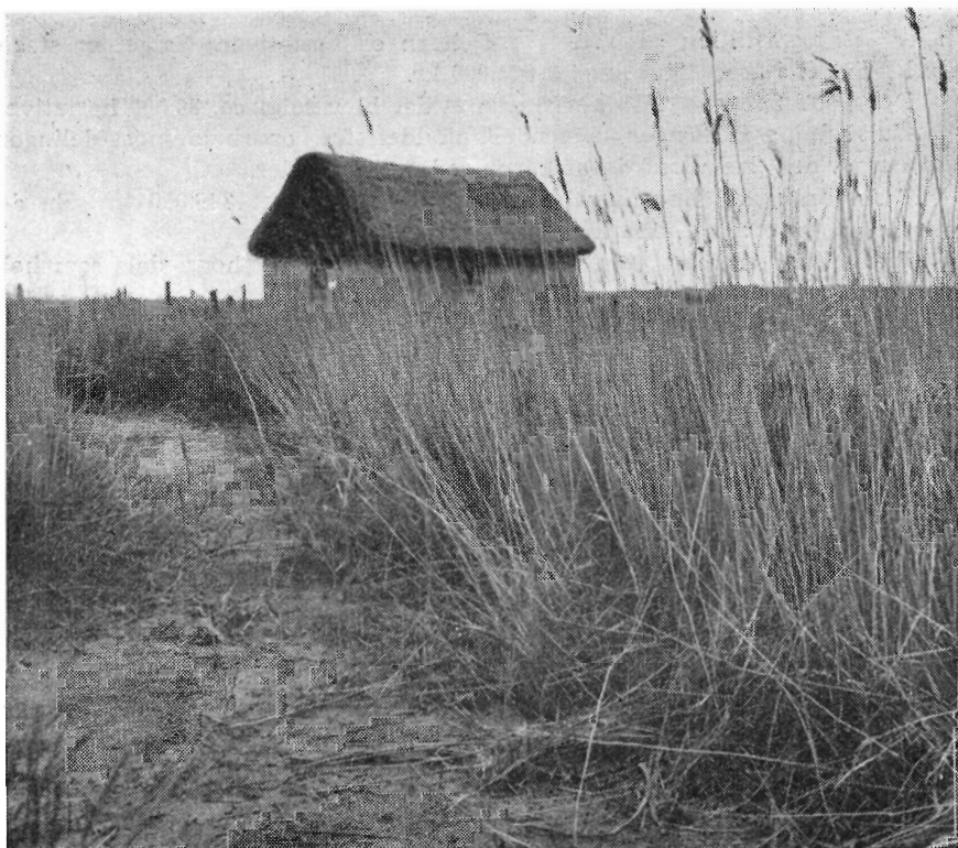
Udsnit af areal under Øster Tørslev enge, hvor et landvindingsarbejde nu er under udførelse. Arbejdet omfatter kunstig afvanding af ca. 420 ha af Tvede, Øster Tørslev og Tørring enge ved Randers fjord. Anlægsudgifterne er anslået til 1,4 mill. kroner.
