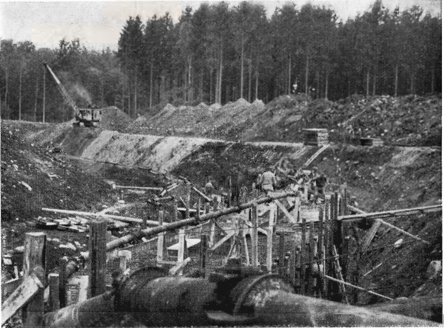
Fra tunnelleringen af åløbet ved Bromølle i anledning af landvindingssagen Åmosen.
