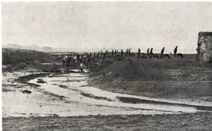
Fig. 3. Billede fra gravning af pumpekanalen ca. 1865. Jordtransporten foregår med trillebør.
