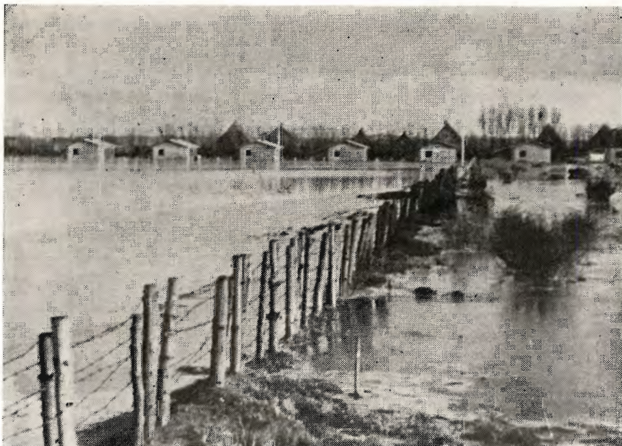
Stormfloden den 17. januar 1954 forårsagede digebrud i Skive-Braarup enge, og engarealerne, der siden anlæggets fuldførelse i 1936 delvis er blevet bebygget med parcelhuse, sattes under vand.
