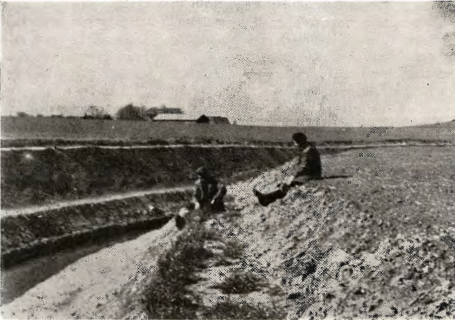
Afløbet fra Skinkelsø og Hagerup sø er færdiggravet, fylden spredt og muldjorden pány påført. Man ser, at terrænet omkring vandløbet er hævet omkring 1 meter. Fyldarealet er derefter tilsået.
