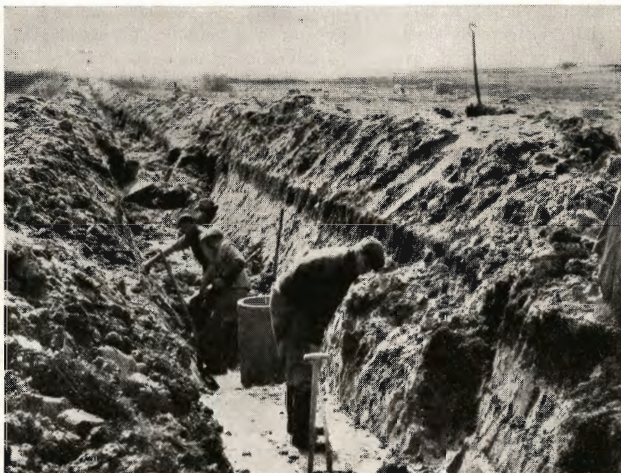
Vanskeligt rørlægningsarbejde i Katbæk.
