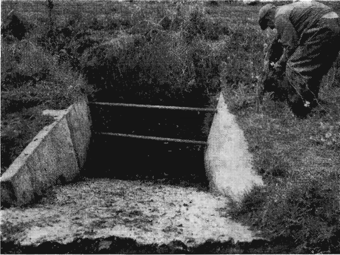
Vandingsstedet med forværk af jernrør og med bund og vægge af beton.
