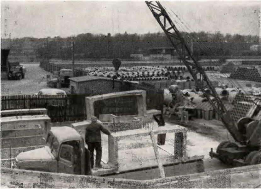
På cementstøberiet læsses de færdige elementer for at transporteres til brugsstedet.
