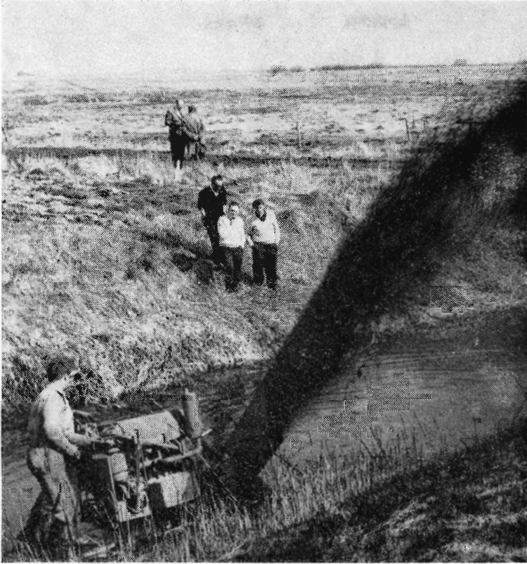
Den store model af »Goldgräber« i arbejde i en landkanal langs diget mellem Højer og Rudbøl.
