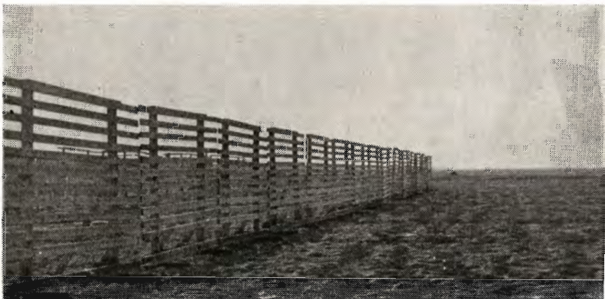
Fig. 20. 2,5 m høj skærm med 45 % hulareal.
