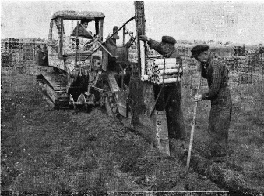
Drængravemaskinen i arbejde. En mand anbringer lerrørene i slidsken, og den bageste mand kontrollerer, at rørene ligger rigtigt i grøften.
