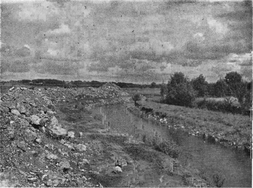
Uddybnings- og reguleringsarbejde i et irsk vandløb. De store stenmængder, der skal fjernes, gør det forståeligt, at omkostningerne ligger på ca. 2000 pd. st. pr. km. Fot. H. S.
