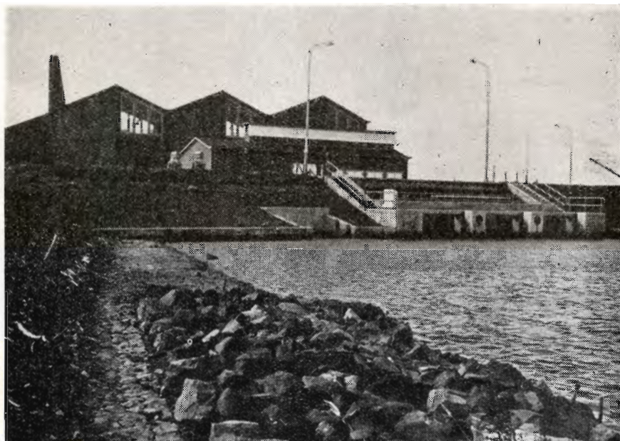
Den nordlige pumpestation i Ost-Flevoland.
