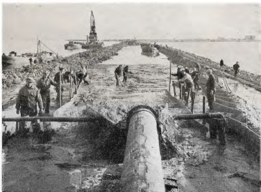
Afslutningsdiget omkring Ost-Flevoland er under bygning. Det indvendige fyld pumpes op.
