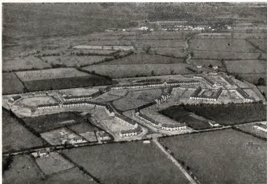
Coill Dubh Village. En af Bord na Monas »byer« med 156 lejligheder og 4 butikker til fastansatte arbejdere. Fabriksbygninger og marketenderis ses i baggrunden.
