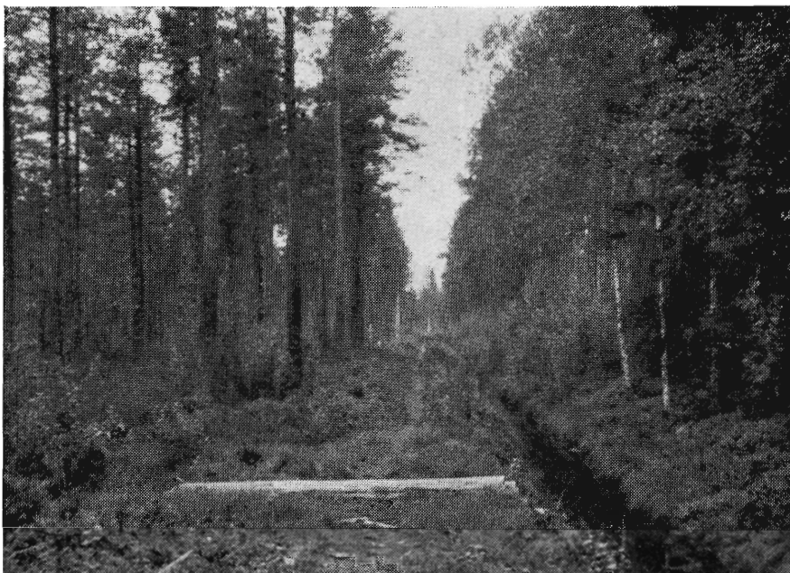
Åben afvandingegrøft gennem skov af skovfyr på lav bund. Overalt i disse områder går færdselsvejene på de faste kanter langs grøfterne.
