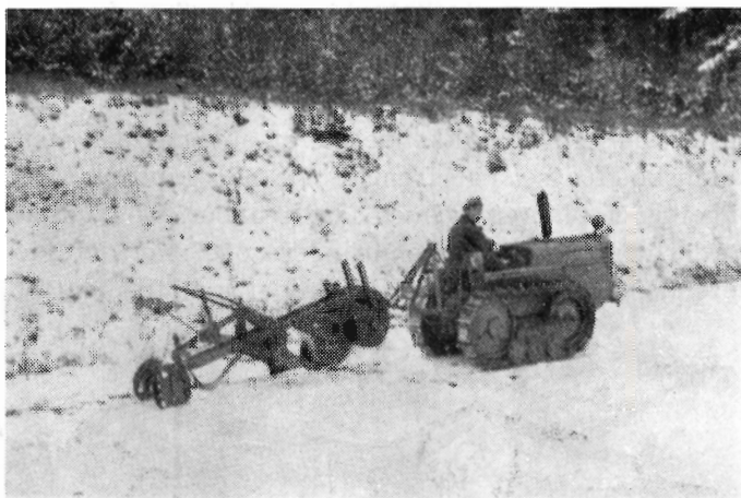
Tolneploven i transportstilling bag »Bristol« larvefodstraktor.
