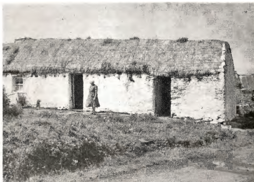
Halvdelen af et beboet kampestenshus i en lille landsby ude ved Atlanterhavet, Nordvestirland. Sådan så ca. hvert 3. hus ud på denne egn. Der er ingen skorstene, tørverøgen fra ildstedet går ud gennem lyren i det lyngtækkede tag. Fot. H. S.
