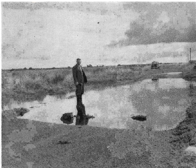
Landevejen var sunket i mosen over ca. 15 meter. Det skyldtes, at store afvandingsarbejder i de omgivende mosearealer havde fået tørvejorden til at sætte sig, hvorefter et regnskyl fyldte sætningen ud. Fot. H. S.
