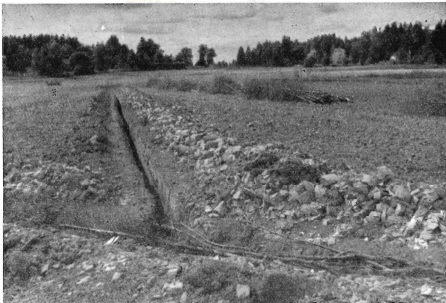
I forgrunden »hovedledningen« fylt op med faskiner, samt en opgravet »sideledning«. Faskin-materialerne ses til højre.
