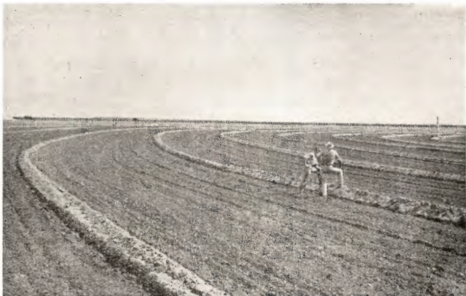
Også en overrislingsmark, men her er markerne anlagt i terrasser, for at arbejdet med terrænregulering kan formindskes.
