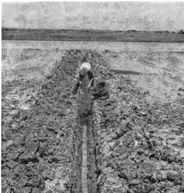
Fig. 2. Pakning af drænledninger med tørvestrøelse.
