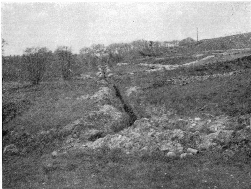
Dræningsarbejdet under udførelse.
