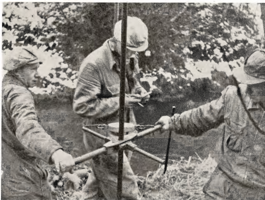
Geotekniske undersøgelser af jordbunden, hvor tunnelen skal bygges. 1954.
