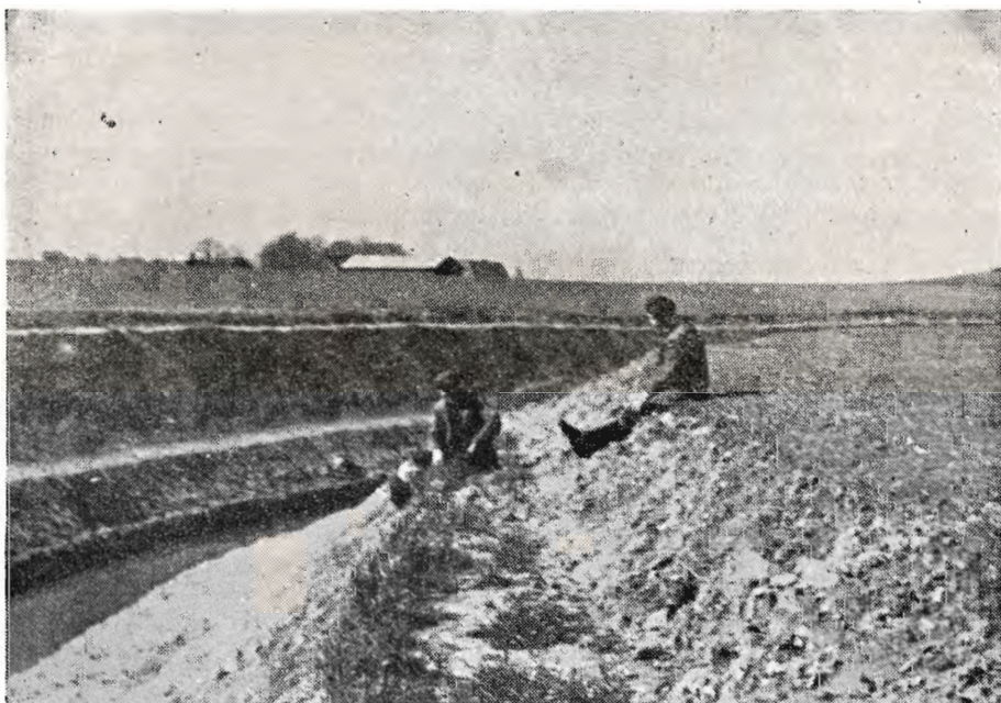
Afløbet fra Skinkelsø og Hagerup sø er færdiggravet, fylden spredt og muldjorden påny påført. Man ser, at terrænet omkring vandløbet er hævet omkring 1 meter. Fyldarealet er derefter tilsået.
