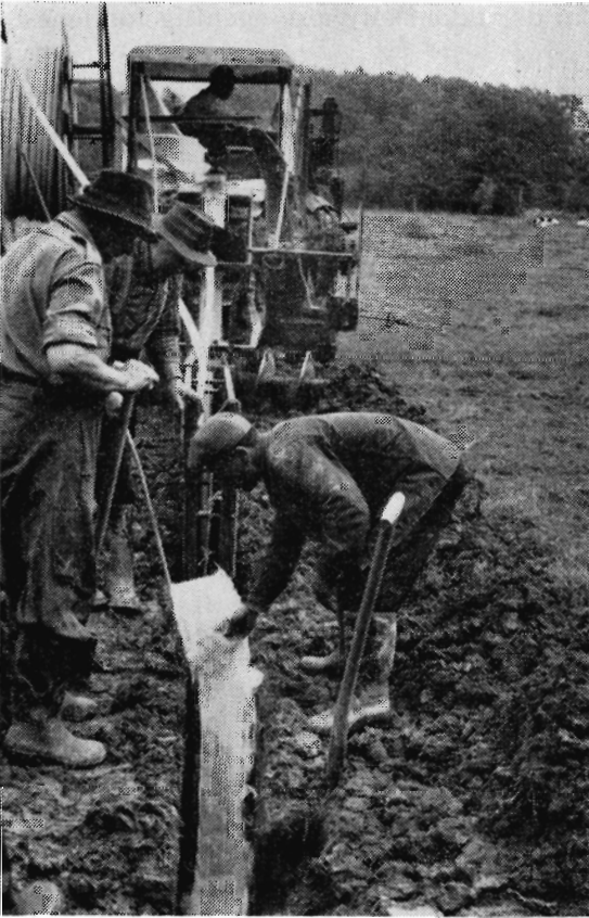
Plastledning sikres mod indtrængning af finsand ved dækning med en glasuldsmatte.
