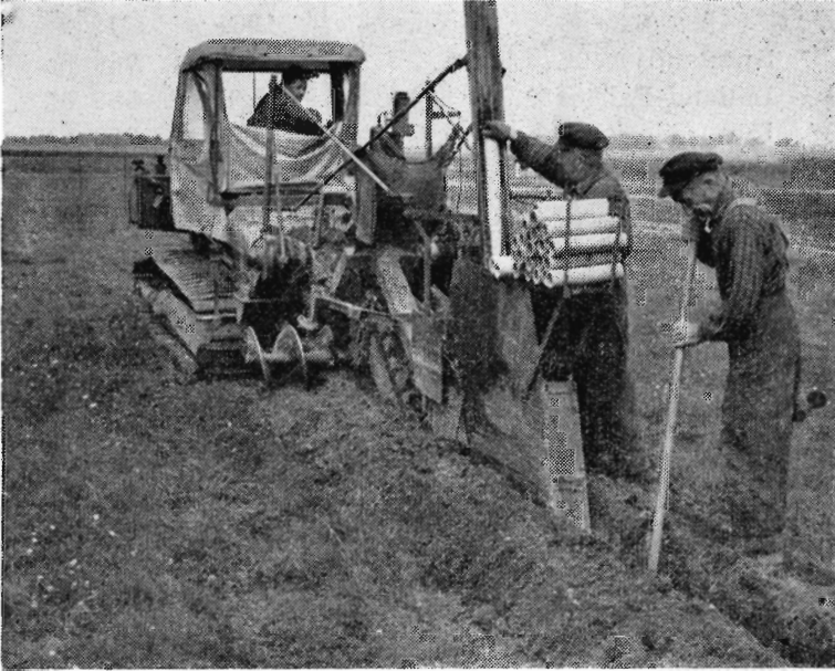
Moderne specialmaskine til nedlægning af almindelige drænrør.
