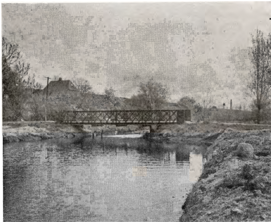
På billedet ses til højre, hvor stærkt det gamle åleje udvides.
