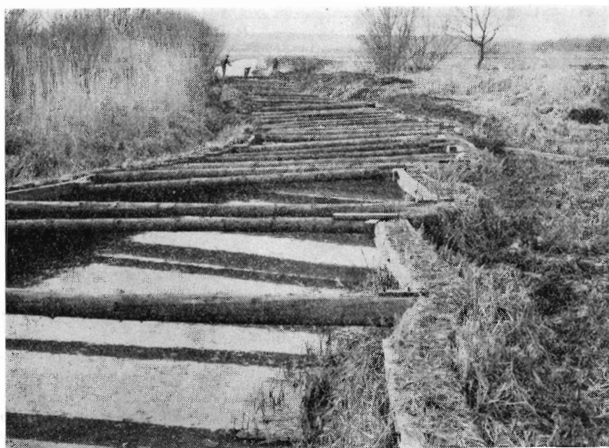
Fig. 3. Kanalen er sikret med pælespuns, langtømmer og tværplanker.
