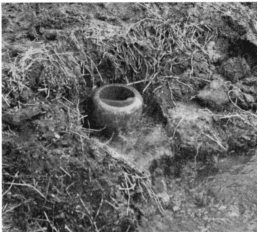
Fig. 6. Stærkt vandførende lodret dræn i linien mod øst.
