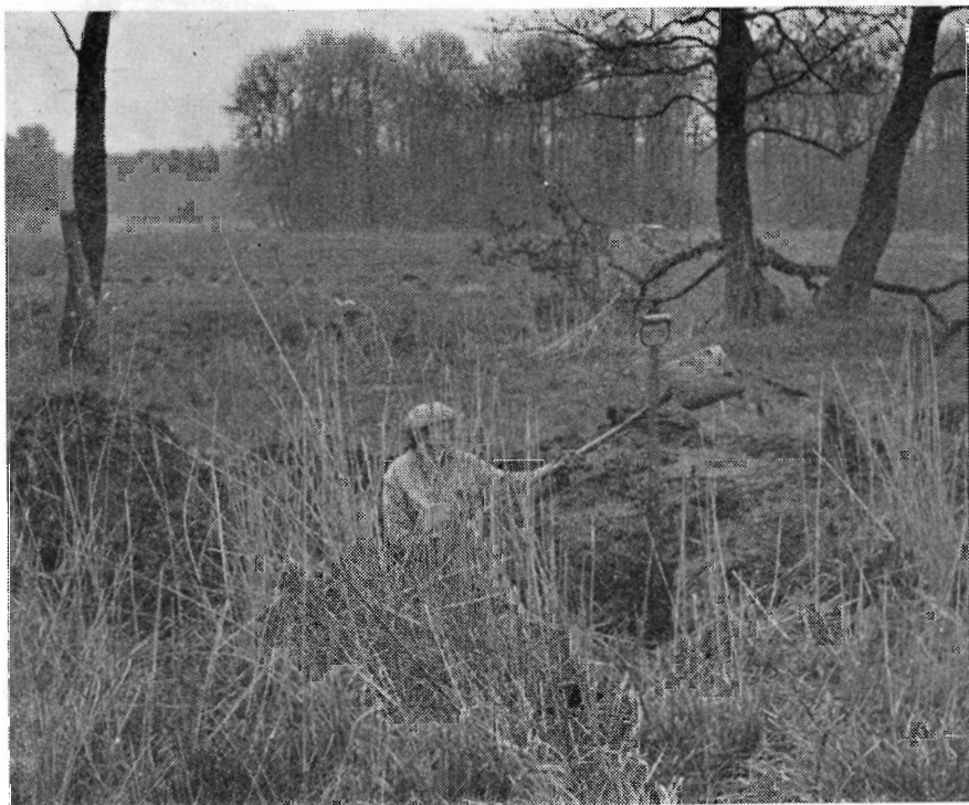
Fig. 4: Der graves op til den østre ledning gennem et blødt og vandfyldt parti.
