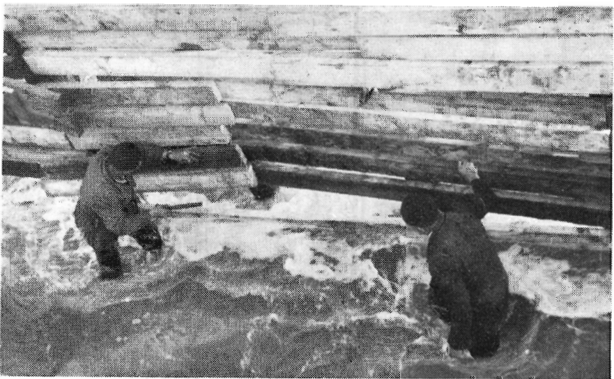
Fig. 2. »Plankeværket« er nu ved ebбетid færdigt, og arbejdernes løbebroer taget op. Disse løbebroer kunne anbringes i forskellig højde og blev sænket, efterhånden som tidevandet sank. Formanden inspicerer til sidst plankerne og udbedrer lidt hist og her.
