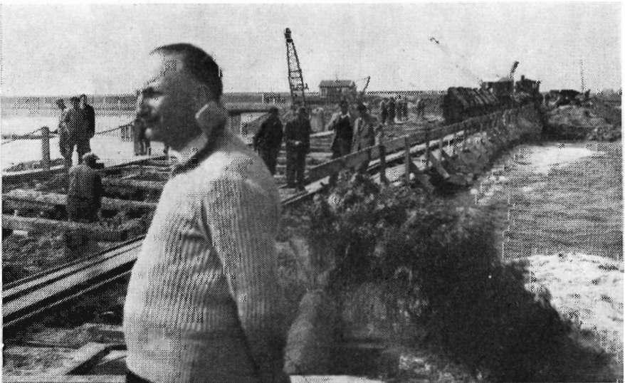
Fig. 5. Vandet er nu ved 14-tiden nået godt 2 m højere op end på fig. 1, der er taget næsten samme sted fra. Ingeniør Dibbits, som er direktør i Rijkswaterstaat, ser alligevel noget betænkelig ud.
