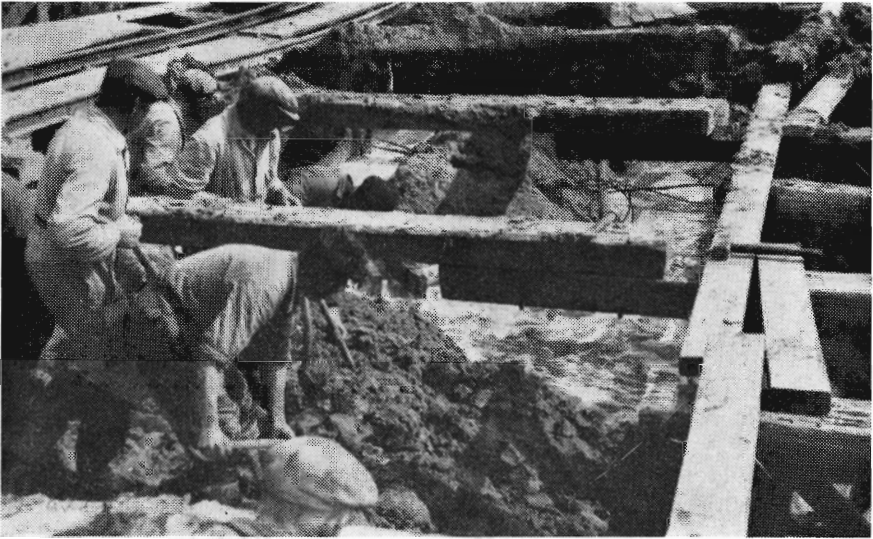
Fig. 8. Den sidste forhåndenværende fyld er brugt, og ydervandet løber nu over digekronen i en spæd strøm. Entreprenøren står i baggrunden og giver gravemesteren besked om at skynde sig endnu mere med at fylde jord på. Der er dog næppe nogen gravemester, der har arbejdet hurtigere end denne mand i hint øjeblik. I desperation giver entreprenøren alle arbejderne ordre til at smide jord på med spader og hopper selv ned på dæmningen.
