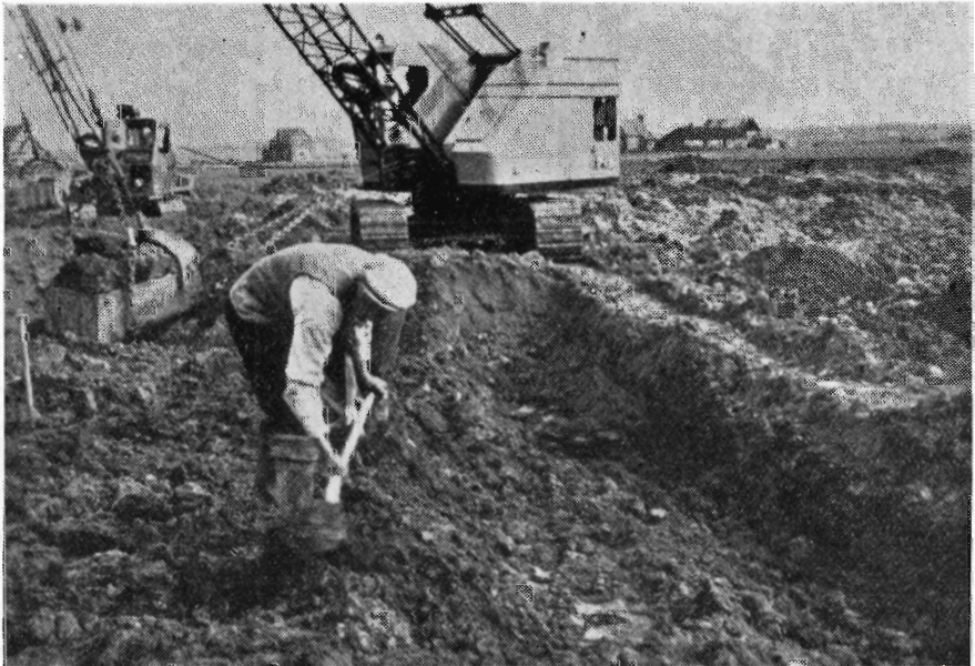
Fig. 2. Jordlagene ombyttes ved hjælp af gravemaskiner. (Schouwen-Duiveland).
