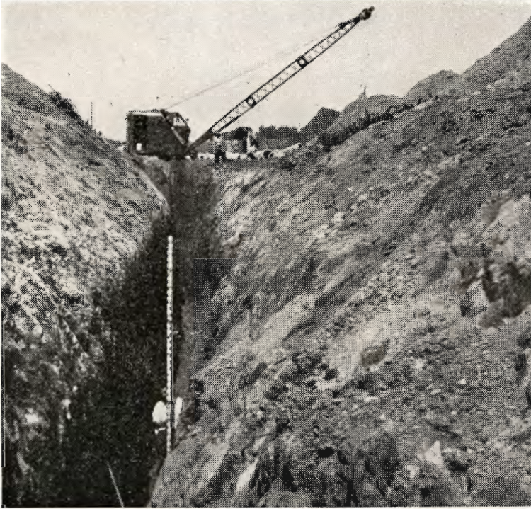
30 cm ledning under udførelse. Største dybde 6,5 m.
