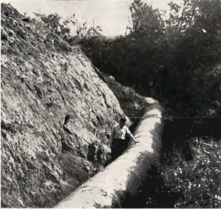
Udækket rørledning lagt efter maskingravning.
