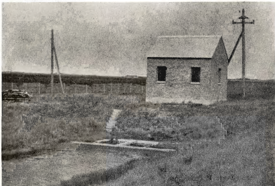
Lundergaard moses største pumpestation set fra indløbssiden. Læskærmene skal hindre tørvestøv i at lægge sig i kanalen. Transformator er indbygget i et særligt aflåset rum i huset.
