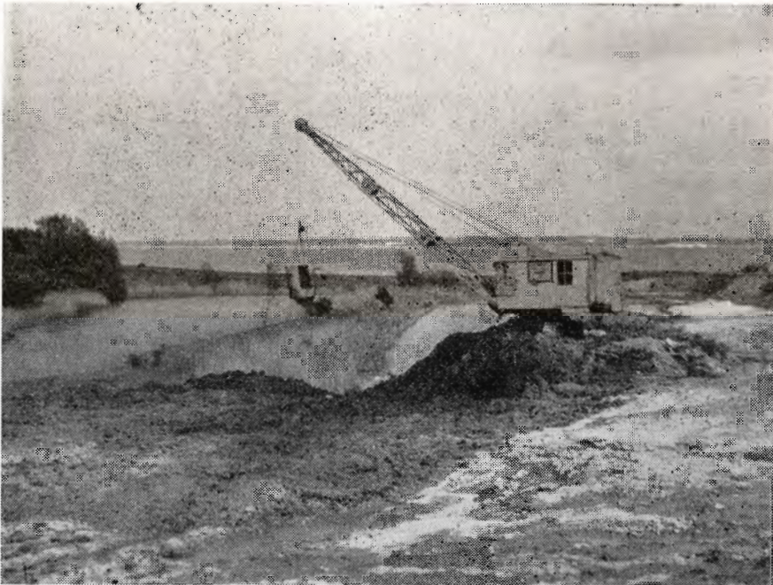
Planeringsarbejde ved den afgravede Marienlyst mergelgrav ved Skive.
