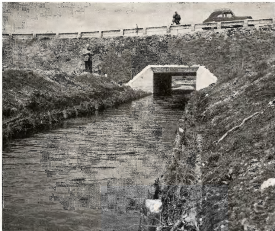
Grætrup bæk er reguleret. Samtidig med omlægning af landevej er bygget en ny underføring.
