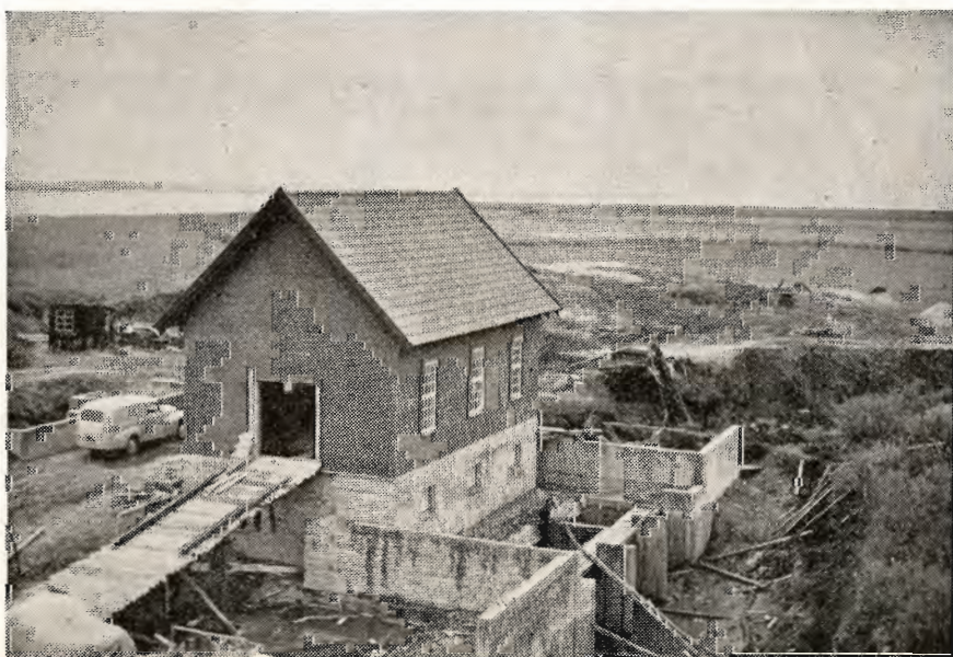
Pumpestationen i Vollum enge, nord for Ringkøbing afvander et område på 2800 ha, hvoraf 1135 ha tidligere var vandlidende. Billederne er fra arbejdets udførelse i sommeren 1955.
