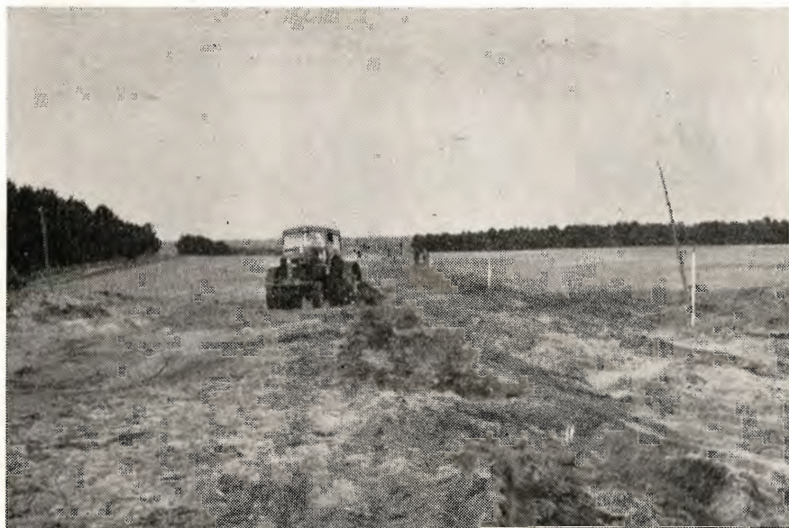
Bulldozer arbejder på en af de nye veje i Sdr. Vium.
