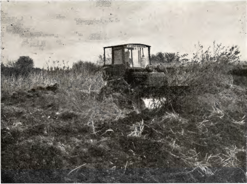
Hedeselskabets bulldozer rydder krat og gamle tørvebalke i en midtjydsk mose, der skal afvandes og kultiveres.
