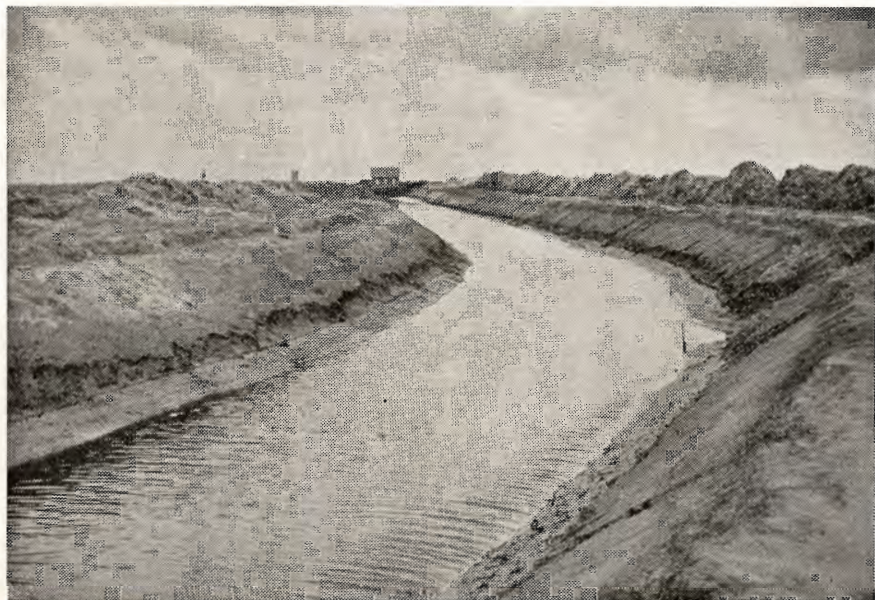
Pumpestationen i Vollum enge, nord for Ringkøbing afvander et område på 2800 ha, hvoraf 1135 ha tidligere var vandlidende. Billederne er fra arbejdets udførelse i sommeren 1955.
