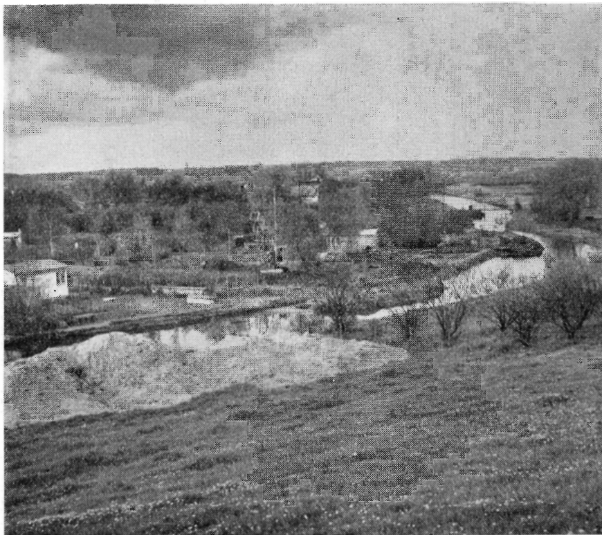
Udsigt over reguleringsarbejde. ved Egaa østfor Grenaa landevej.
