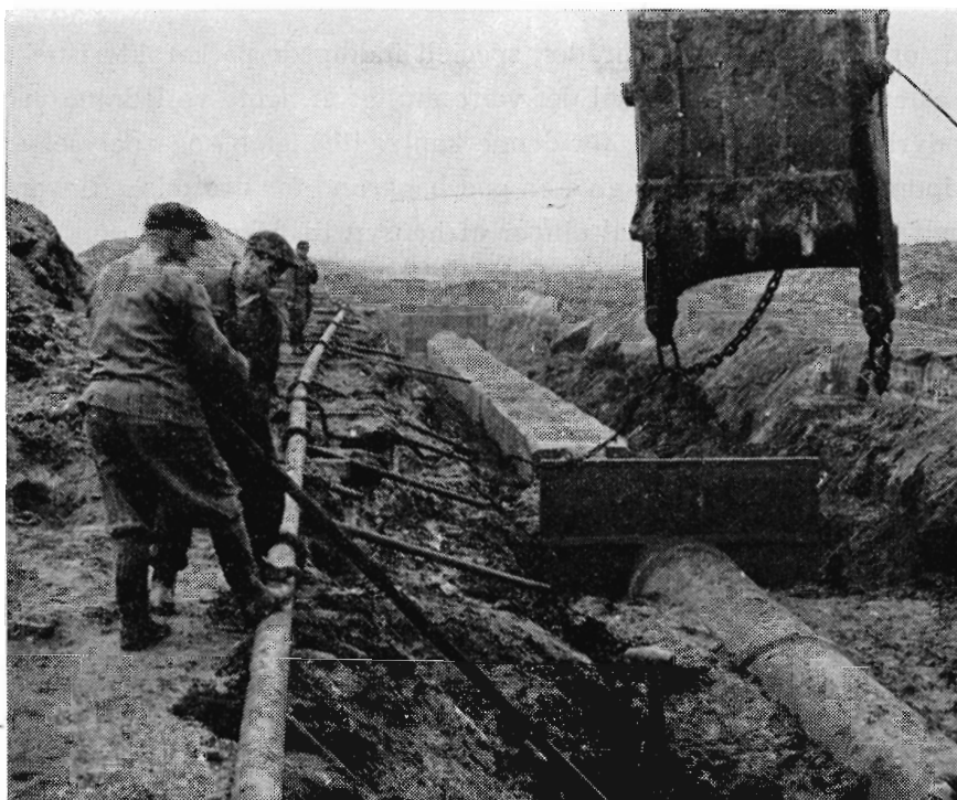
Underløb under Skjern å ved Albæk. Rørene har en åbning på 122 cm i diameter, fot. decbr. 1962.
