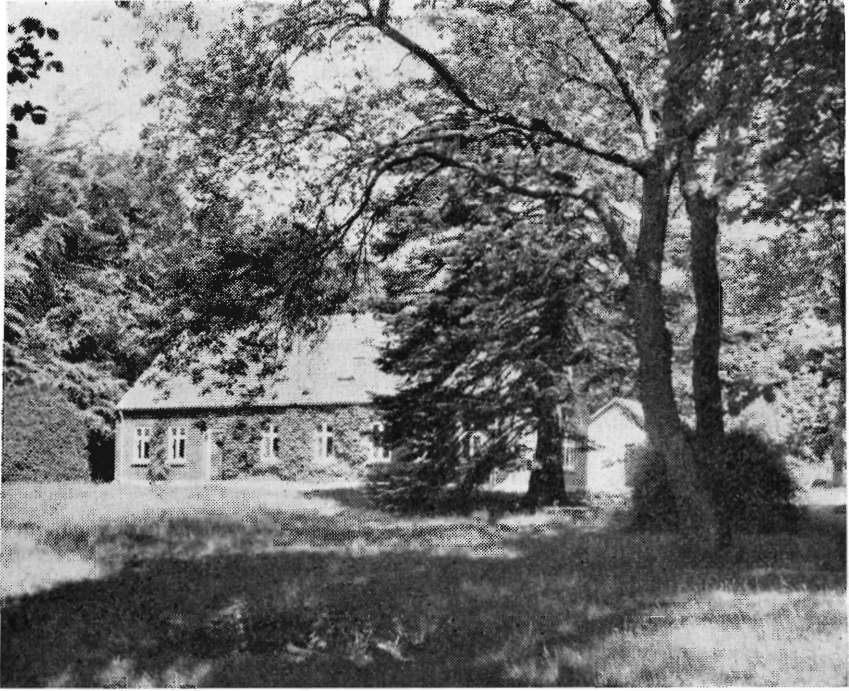
Skovriderboligen i Gatten, der er blevet moderniseret.
